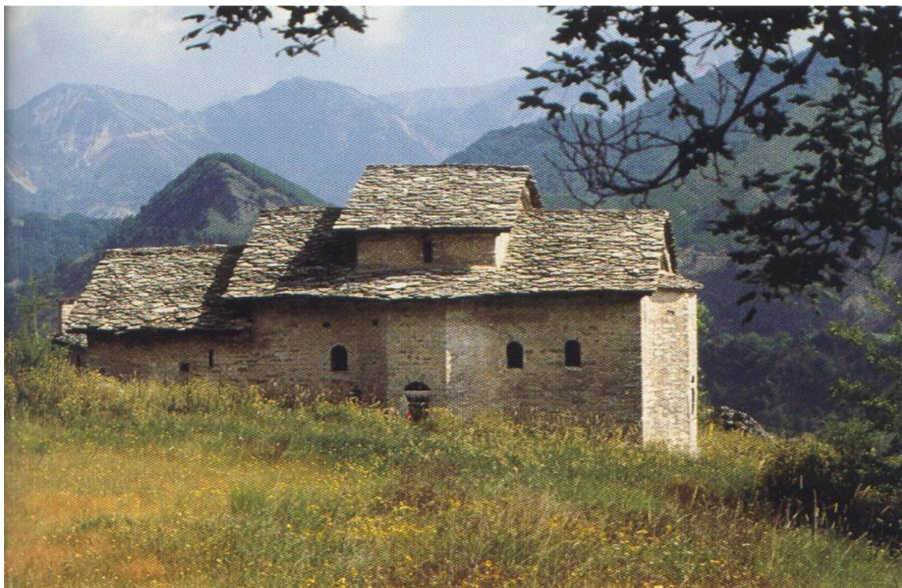
εικ. 8 Άποψη της βόρειας και ανατολικής πλευράς του καθολικού της Ι.Μ. Κοιμήσεως Θεοτόκου ή Σέλτσου
