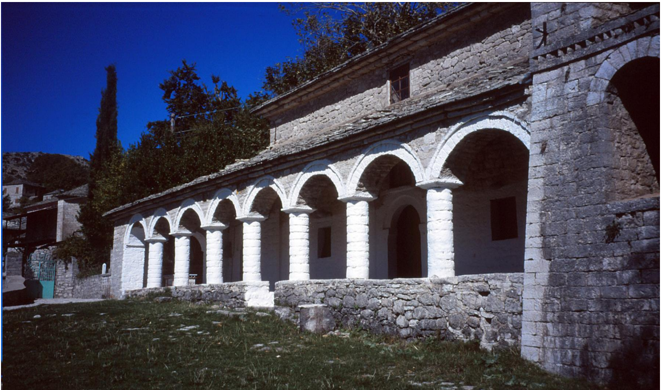
εικ. 12 Άποψη της δυτικής πλευράς του Ι.Ν. Αγίου Νικολάου Καλαρρυτών
