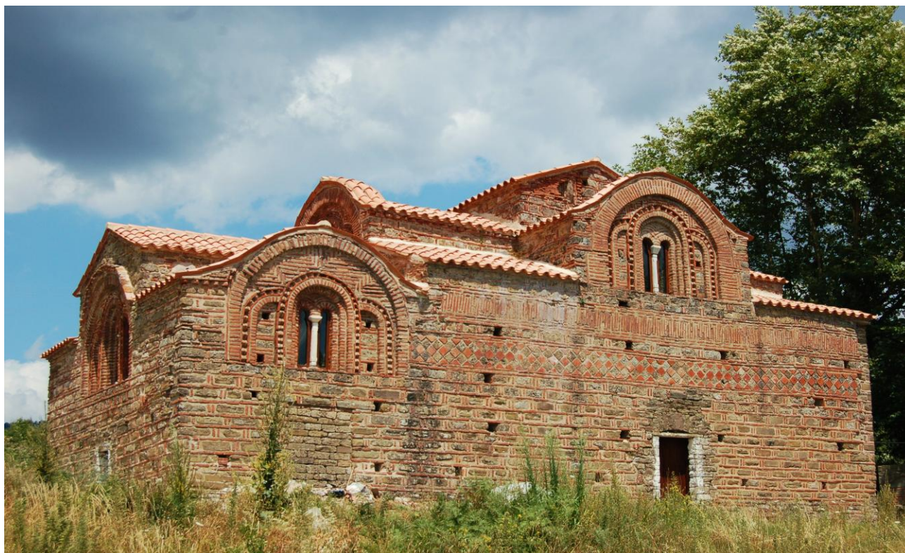
εικ. 3 α Άποψη της δυτικής και νότιας πλευράς του καθολικού της Κόκκινης Εκκλησιάς
